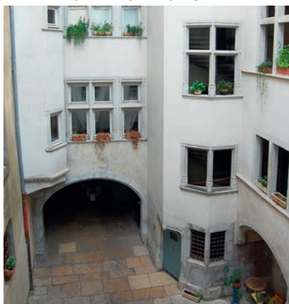
© PATRIMOINE ET DÉVELOPPEMENT DU GRAND GRENOBLE
