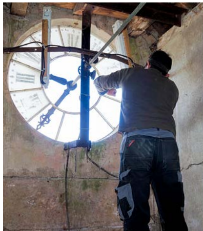
RESTAURATION DE L'HORLOGE DE SAINT-SIMÉON-DE-BRESSIEUX EN 2019 PAR L'ENTREPRISE PRÊTRE
